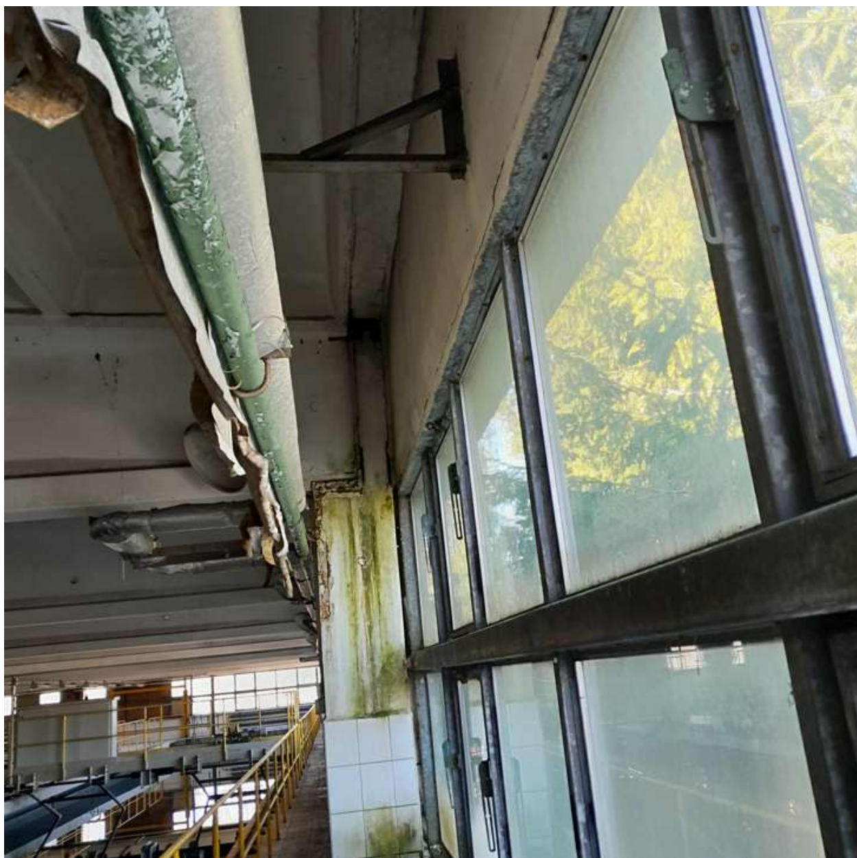
fot 1. Budynek koagulacji
