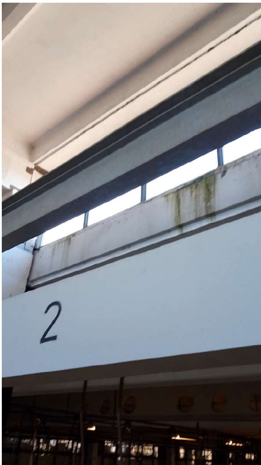
fot 4. Budynek koagulacji
