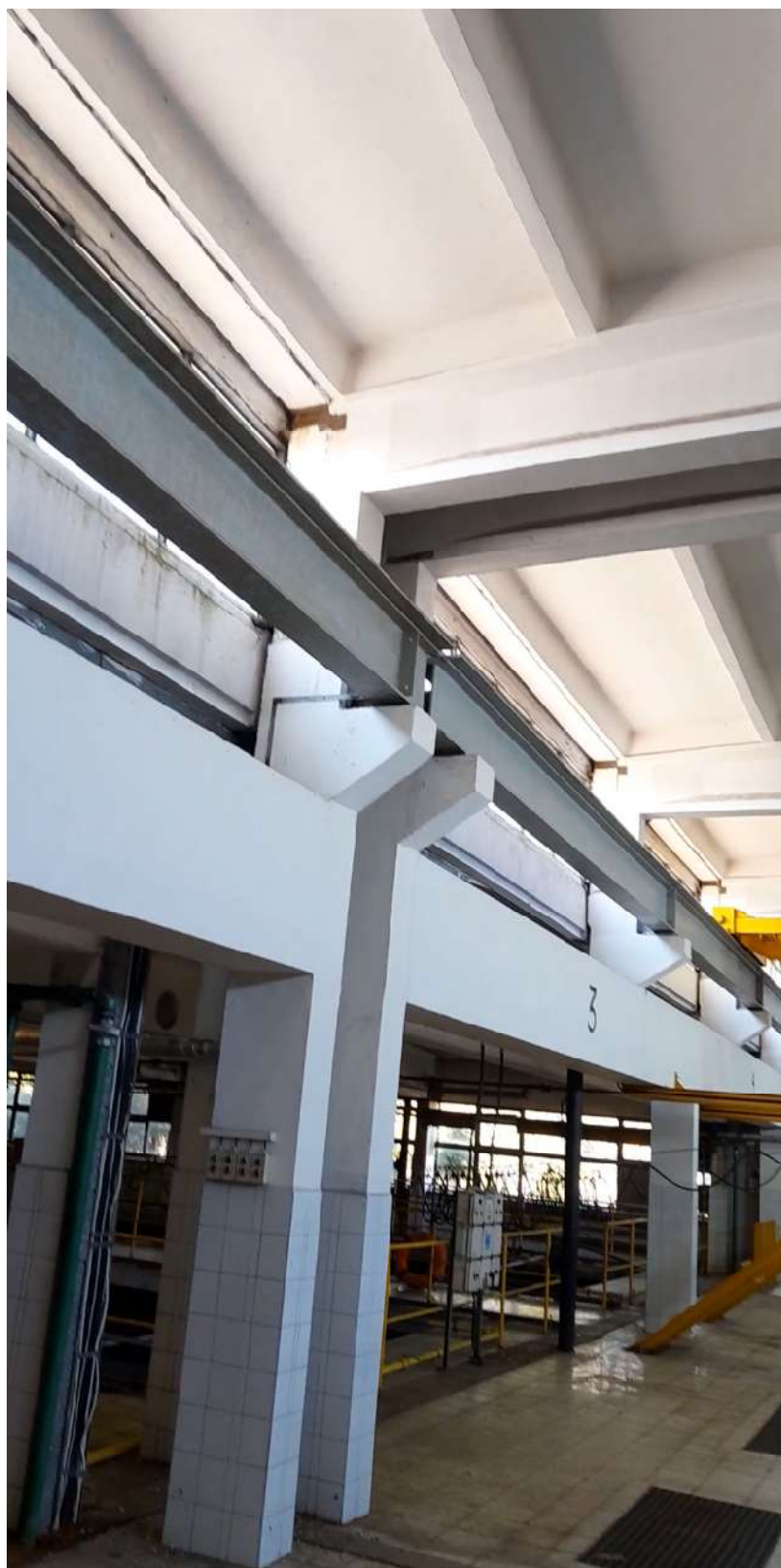
fot 2. Budynek koagulacji
