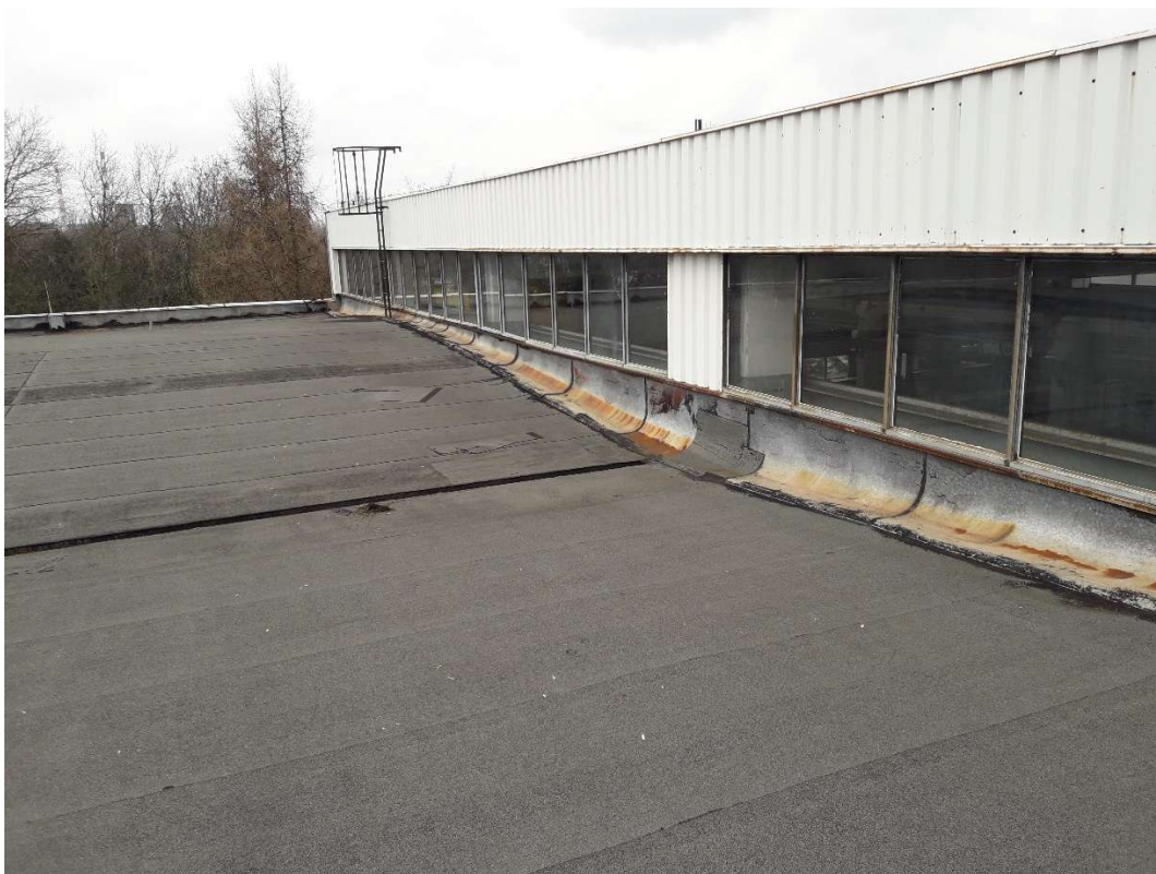
fot 5. Budynek koagulacji
