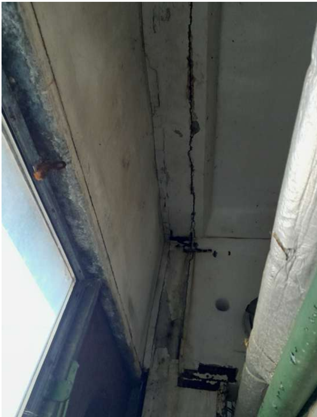
fot 3. Budynek koagulacji
